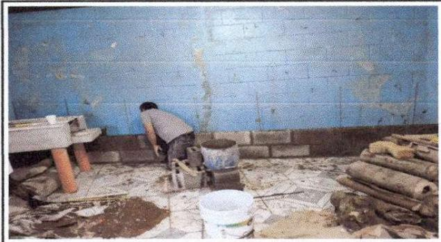
Foto 3: trabajos de levantamiento de pared y realización de cuneta en la cocina para evitar filtración de agua
