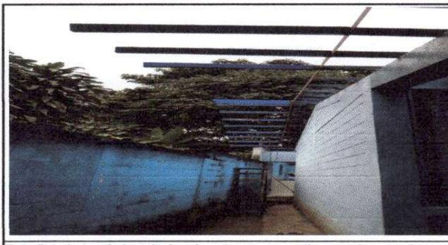
Foto 5: trabajos de instalación de estructura metálica para luego colocar laminas para evitar que los niños se mojen al recorrer los módulos de la escuela.
