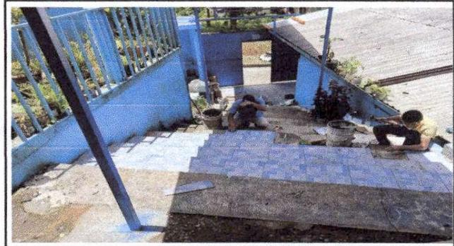
Foto 4: trabajos de colocación de piso cerámico en gradas de la escuela.
